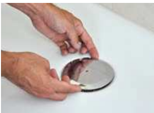
1 Sifonabdeckung entfernen
