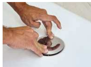
9 Sifonabdeckung einsetzen
