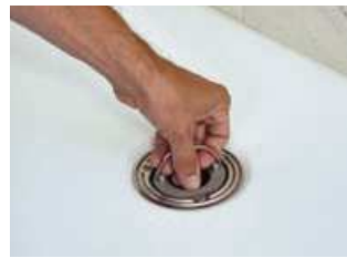
7 Sifoniereinsatz einsetzen
