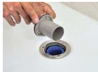
6 Es empfiehlt sich die Dicht- ringe für einen einfacheren Zusammenbau mit Seife zu schmieren.
