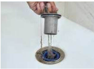
2 Sifoniereinsatz am Bügel herausziehen
