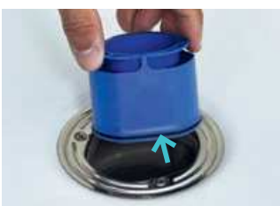
5 Sifontrennwand mit Dichtring nach unten einfügen.
